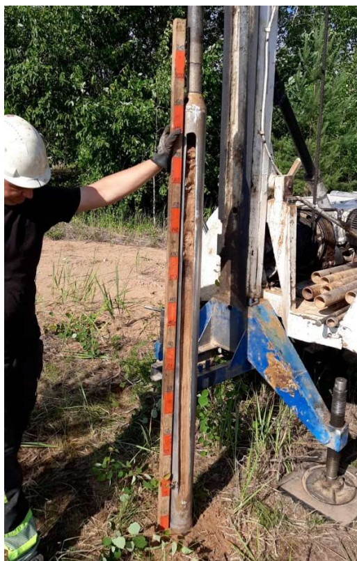
Foto 4.1. Puurauk Pa-15 puurimine Pannjärve uuringuruumis (foto M. Karimov, 06.07.2021. a, N 59°16'47" ja E 27°33'35")
